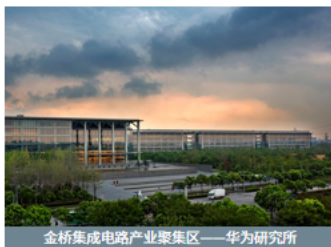
金桥集成电路产业聚集区——华为研究所
